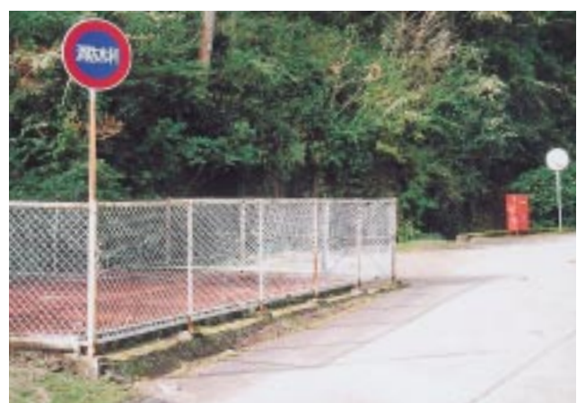
防火用水と消火栓（鹿塩地内）
