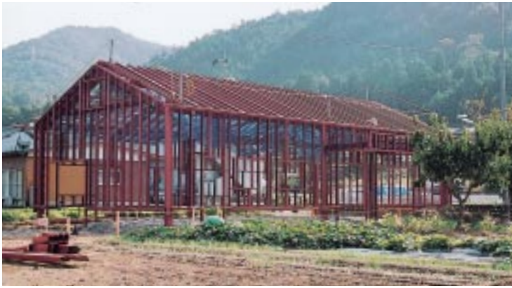
建設が始まった下吉田地区(下)集会所
