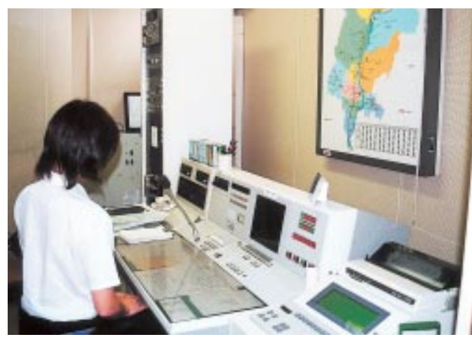
役場の2階に設置されている防災無線室
