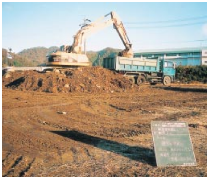
処分材積み込み状況(15年12月)
