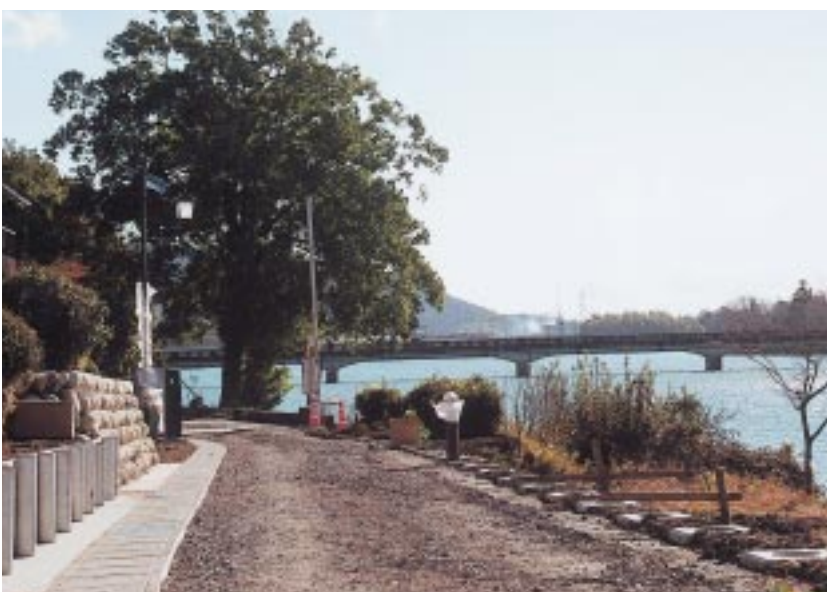
工事が進む左岸遊歩道
