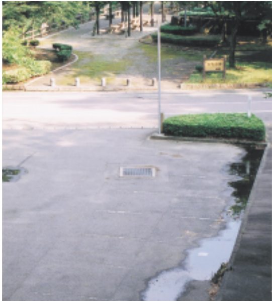
大谷公園駐車場(7月14日撮影)
