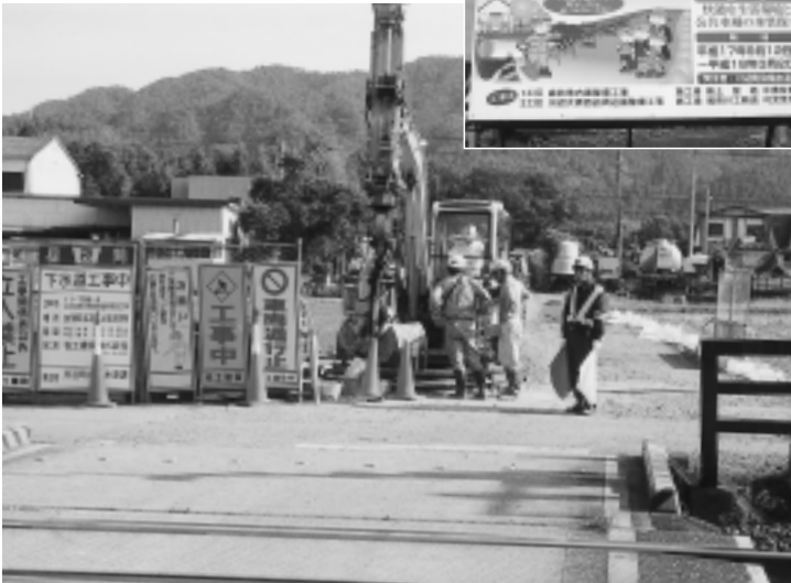
下水道工事 上川辺地内
