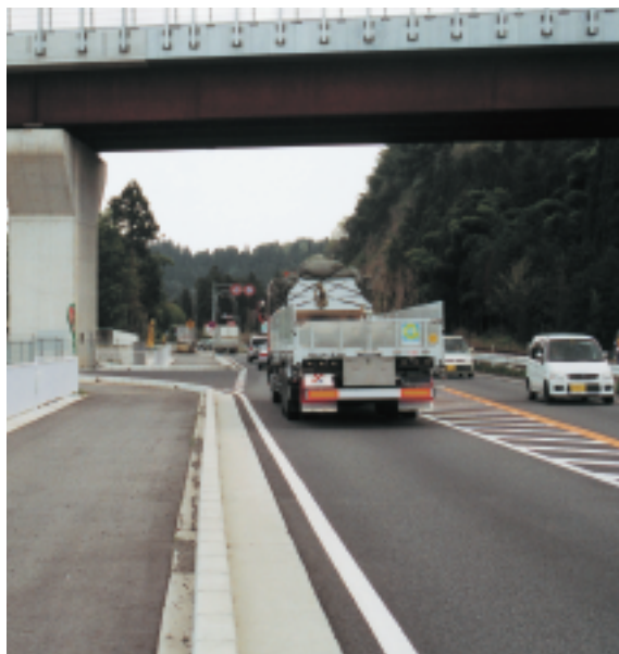
国道41号線と町道との交差点(下川辺地内)
