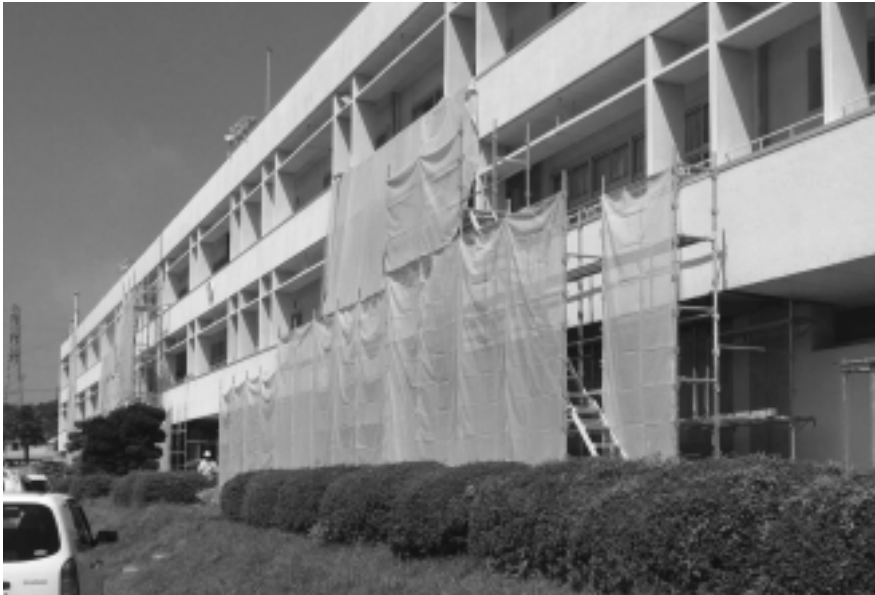
西小学校校舎の耐震補強工事始まる（7月31日撮影）
