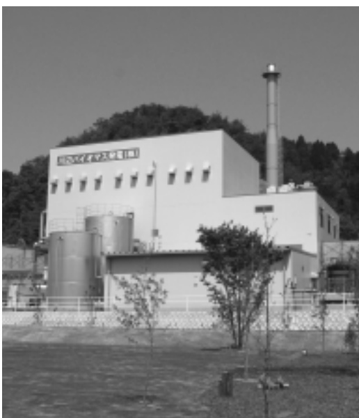
バイオマス発電施設 (5月撮影)
