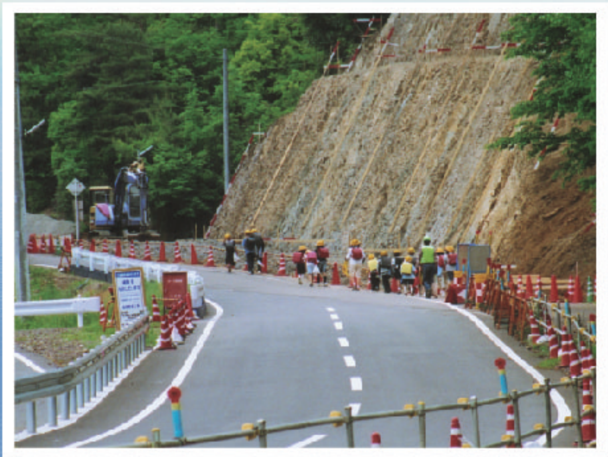
完成間近、主要地方道 美濃一川辺線 拡幅改良工事(大谷公園付近) 5月2日
