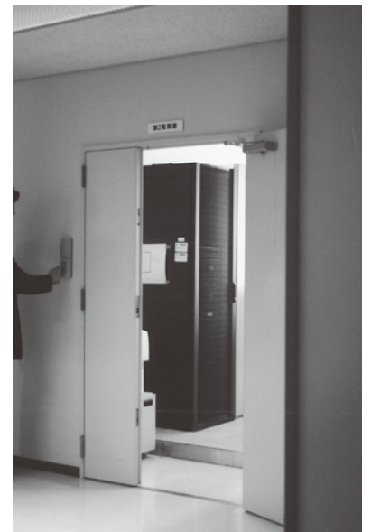
第2電算室(庁舎3階)
