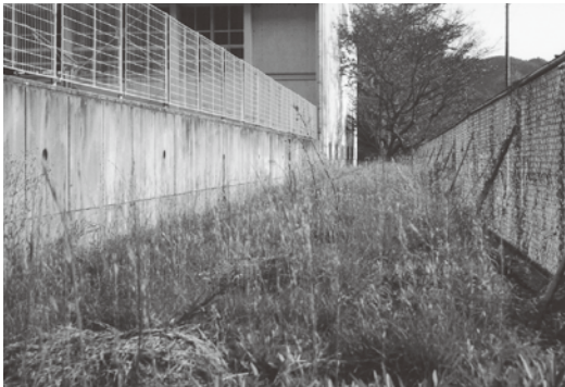
北小学校敷地内(11月撮影)
