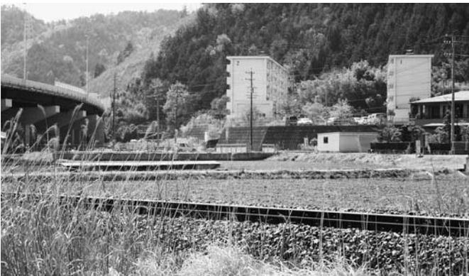
美濃加茂バイパス沿いの川辺宿舎
