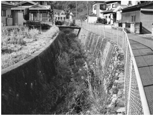
改修を待つ水無瀬川
