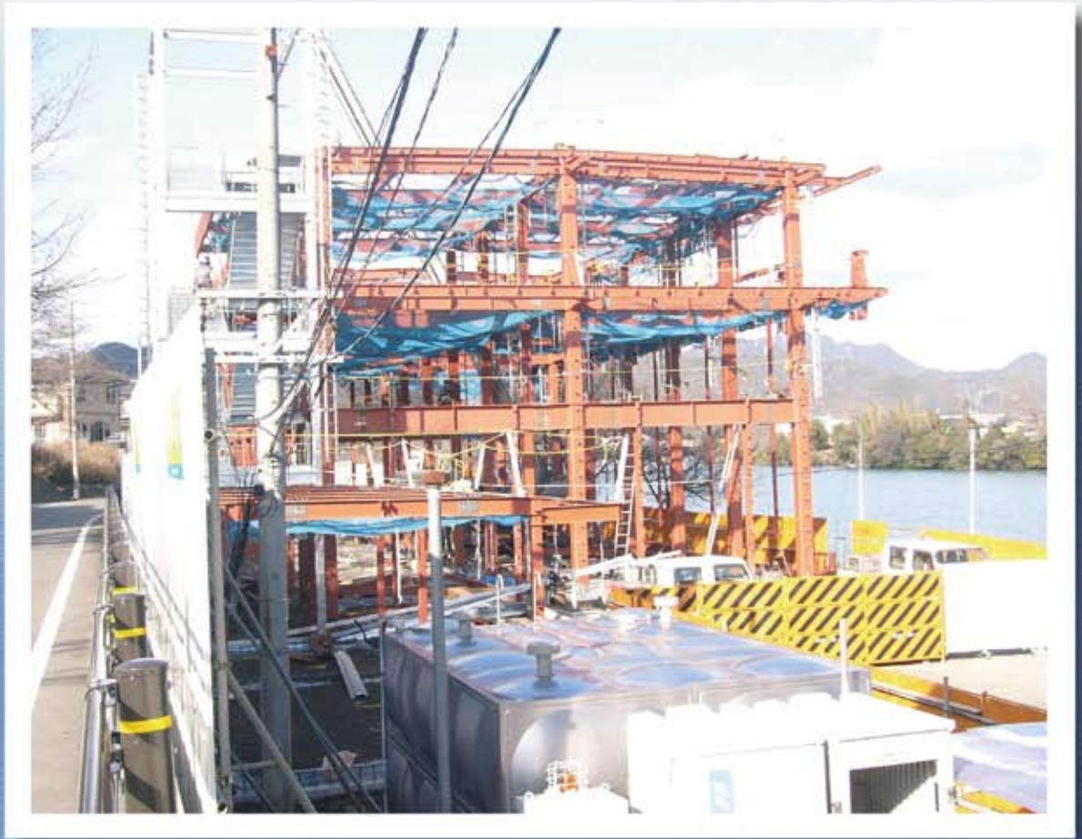
6月完成予定の岐阜県川辺漕艇場（1月撮影）
