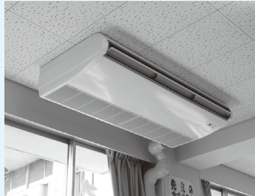
(中学校空調設備)
