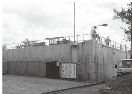
(工事中の山楠配水池)
