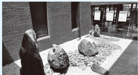
（修繕予定の中央公民館中庭）
