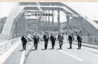
新山川橋開通
