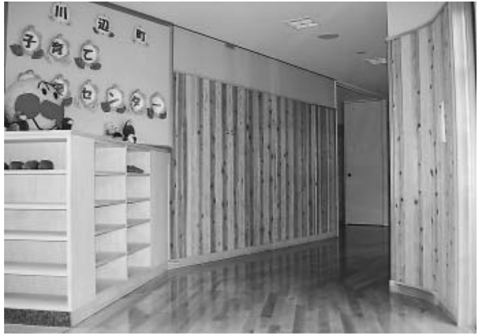
第三保育所内装木板張り
