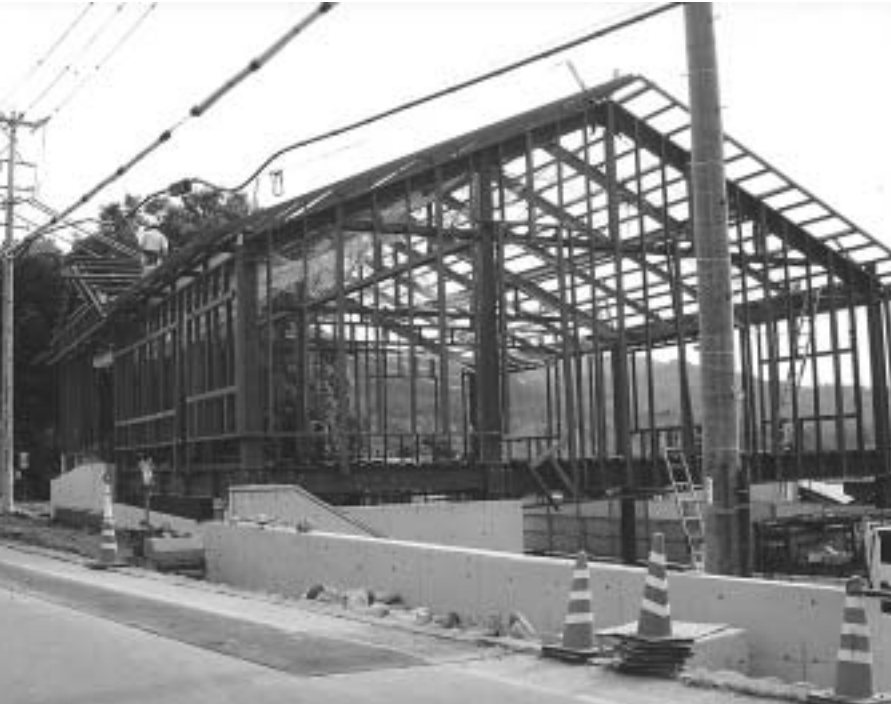
建設が進む北部公民館（下麻生地内）
