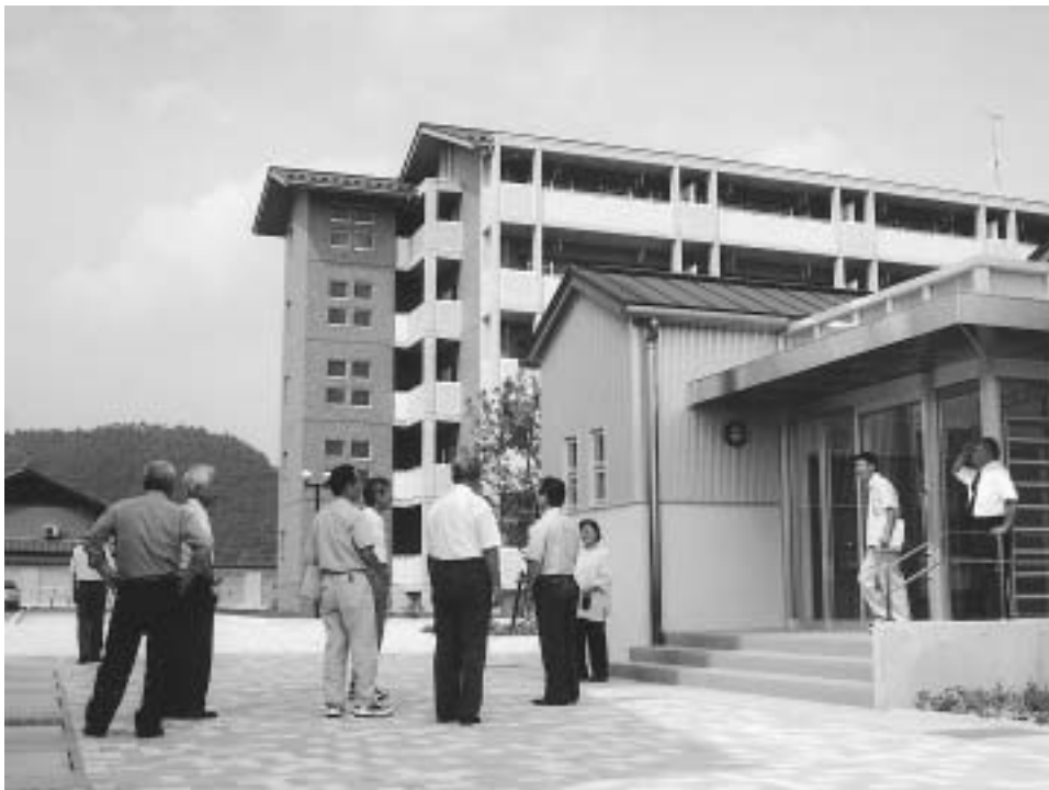
委員による現地視察(川辺西タウン)
