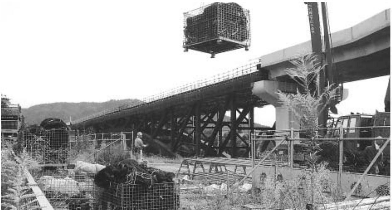
工事が着々と進む東海環状自動車道
