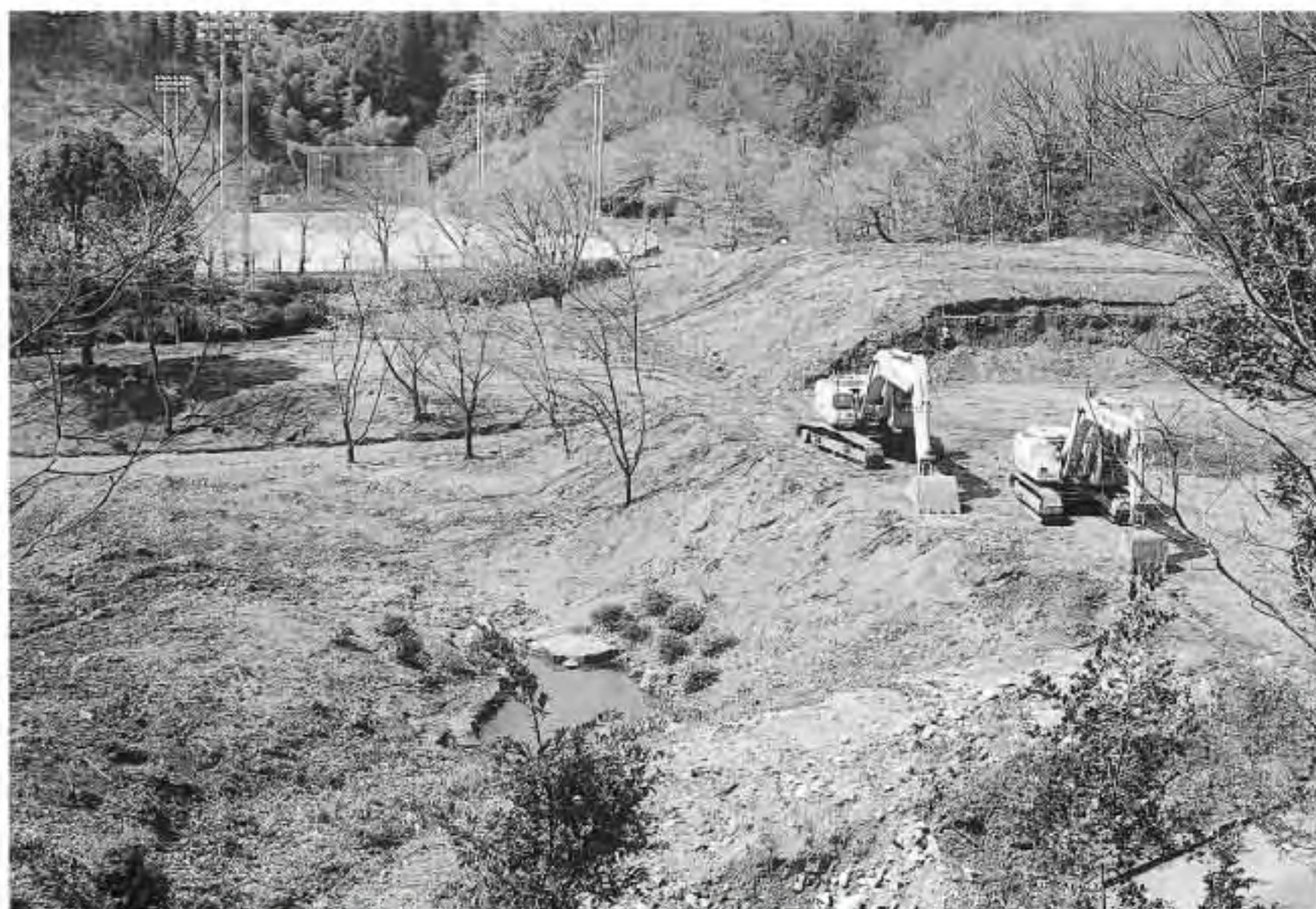
国道41号バイパスに関連する再整備工事が始まった山楠公園(3月31日撮影)
