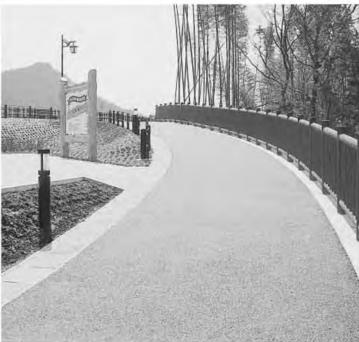
一部完成した左岸遊歩道(比久見地内)
