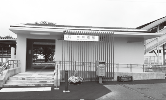
(新しくなった中川辺駅舎)
