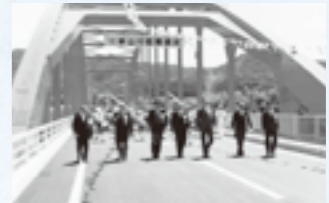
昭和58年 新山川橋完成
