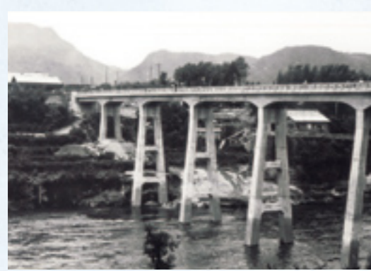
山川橋(昭和12年竣工時)
