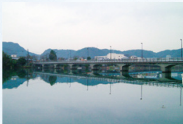
平成22年 「山川橋」改修工事終了
