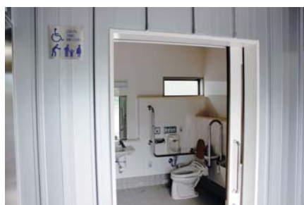
艇庫の脇には倉庫とトイレを設置
