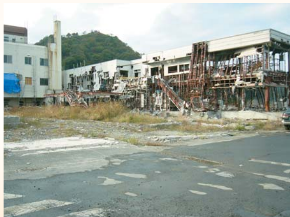
【鉄筋がむき出し状態の建物】
