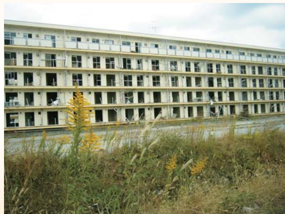
【4階まで壊滅した集合住宅】
