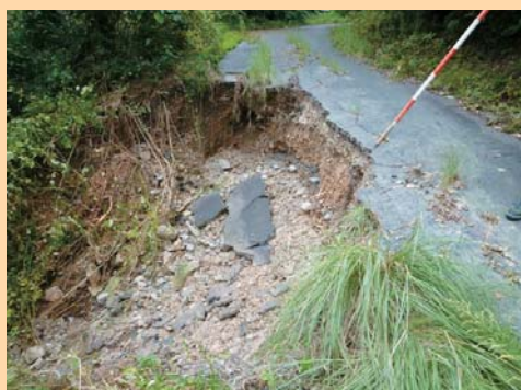
【上川辺 黒谷林道の崩壊】
