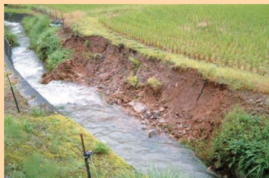
【上川辺 神坂川の護岸崩壊】
