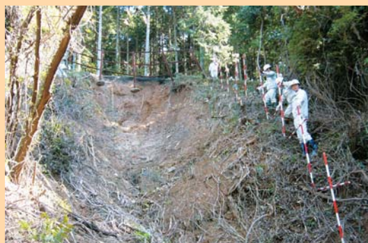
【上川辺 町道神坂線 路肩の崩壊】
