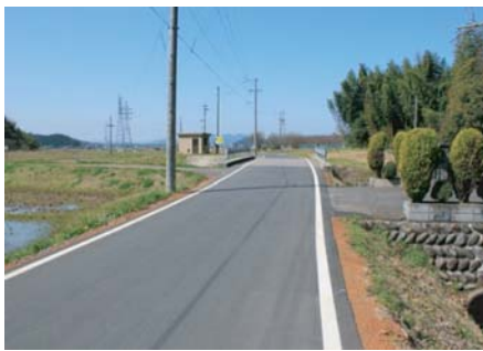
舗装した町道鳥ヶ下線(福島地内)
