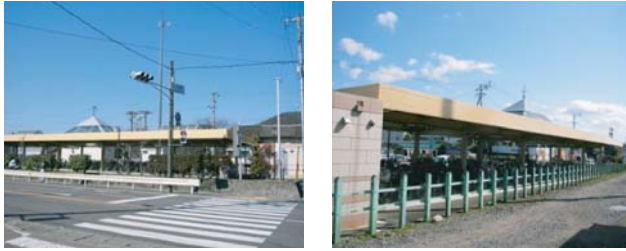
塗装を施した中川辺駅前駐輪場
