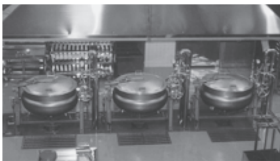
町給食センターの調理釜
