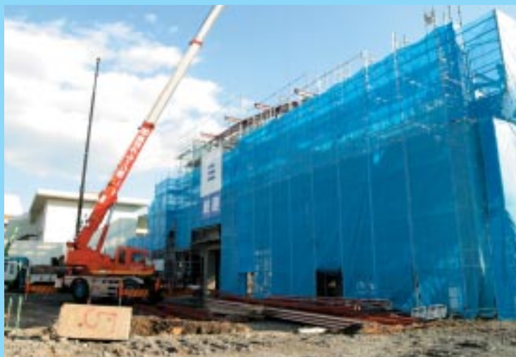
・昭和35年に建てられた屋内運動場は、今年の卒業式に間に合わせるよう急ピッチで立て替え工事が進んでいます。
