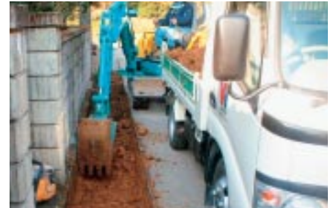
道路改良工事の様子
