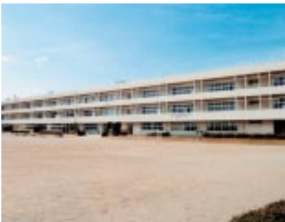
耐震補強工事を行う西小学校校舎
