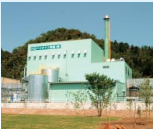
完成したバイオマス発電所
