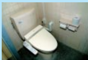
新設された洋式トイレ
