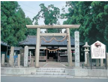
栃井神社（現在建て替え工事中）
