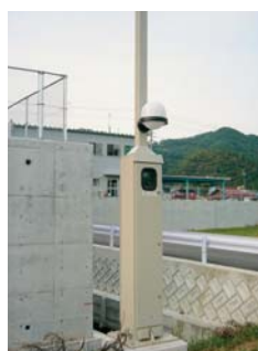
マンホールポンプ制御盤
