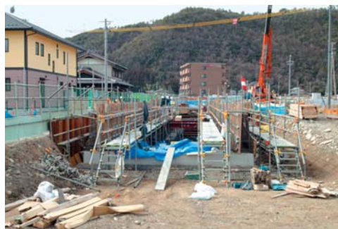
工事が進む地下道部
