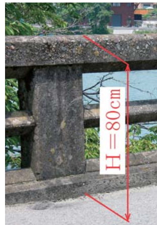
高さ、強度ともに不十分な現在の高欄
