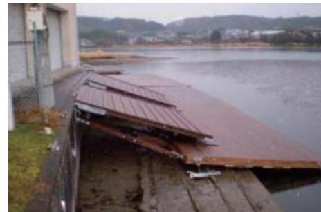
水位低下のため、普段は川面に浮く 棧橋が河床についてしまっています。
