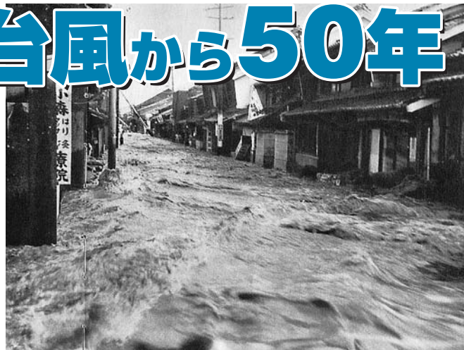
降雨量毎時40~70の豪雨により、河川が氾濫し、道路が激流と化した。(岐阜市)
