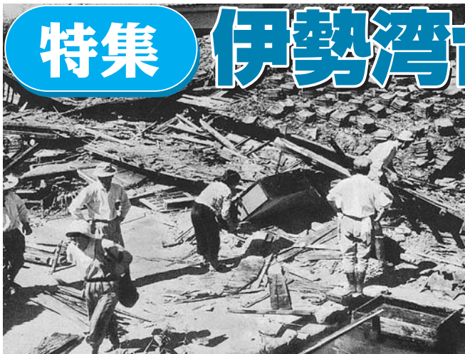
強風により多くの家屋が倒壊した。(中津川市)
