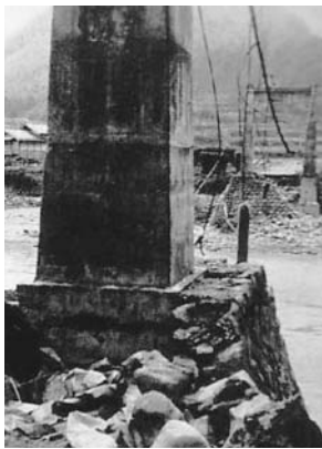
多くの橋梁が流失し、交通が分断された。(美濃市)
