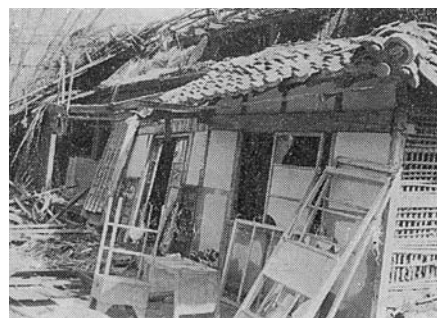
川辺町でも家屋倒壊など相次いだ。(川辺町)
