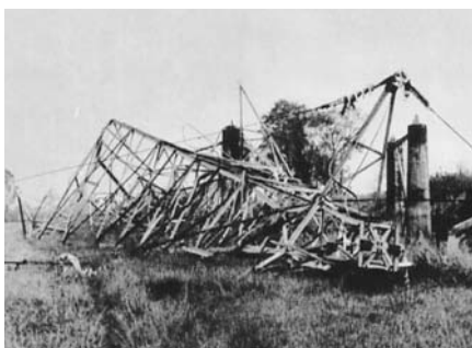
強風でへし折られた鉄塔
