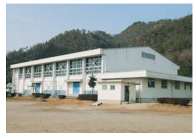
耐震補強された北小学校屋内運動場
