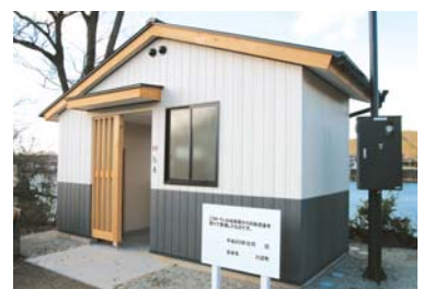
左岸遊歩道トイレ
