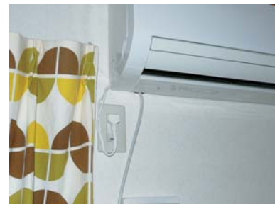
エアコンの穴から引き込んだ例
