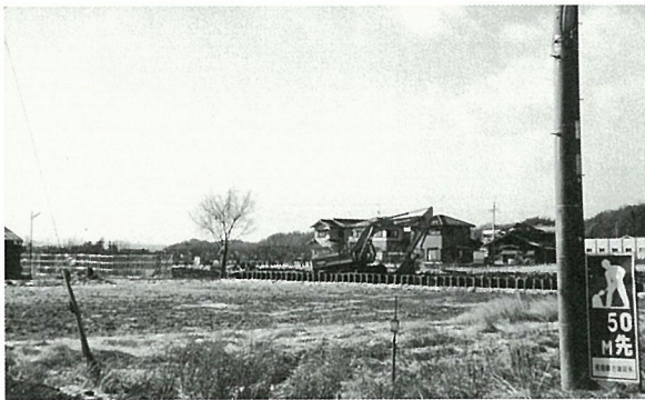
造成工事の始まった
