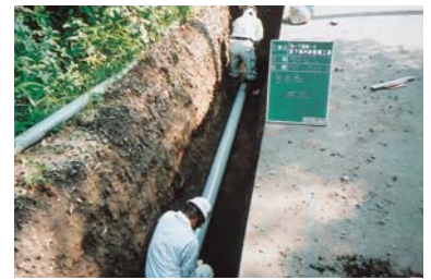
下水道工事の様子
