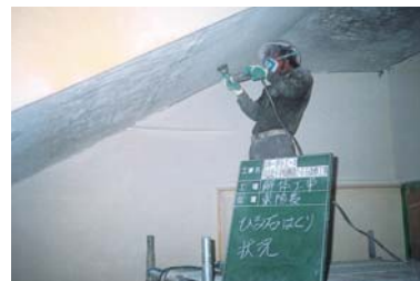
ひる石の撤去作業の様子（北小学校）
