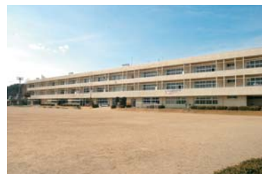
耐震補強工事がされた西小学校校舎
