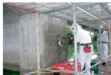
山川橋の点検作業の様子
