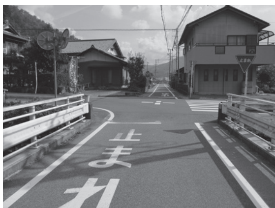
区画線・路肩の着色の様子
