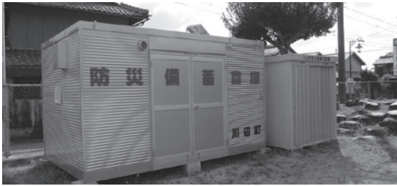
備蓄倉庫・資機材倉庫
