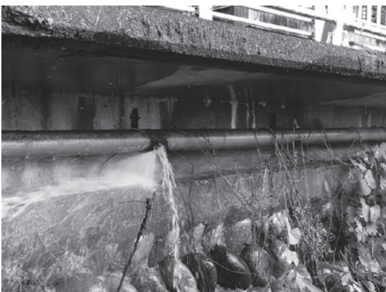
配水管漏水(下川辺地内)の様子
