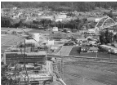
美濃加茂バイパスと国道41号線との接続付近を望む
