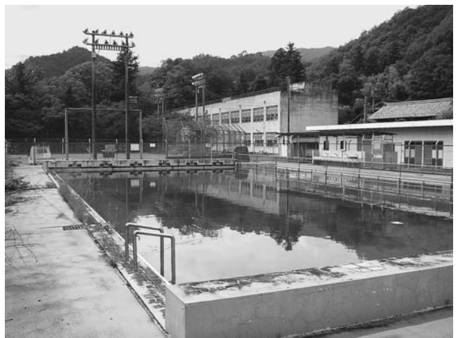
旧下麻生小学校
