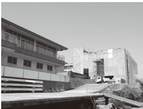
建設中の新艇庫
