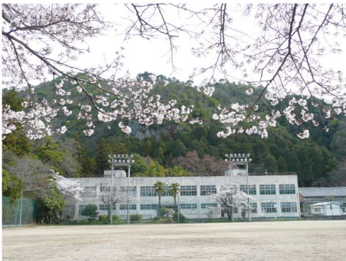
取り壊し予定の旧下麻生小学校（23年4月撮影）
