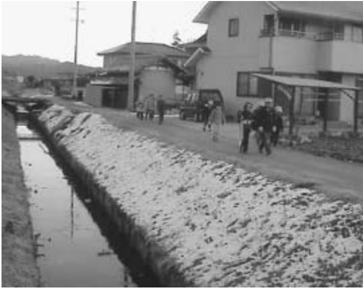
排水路と並行している道路(石神地内)
