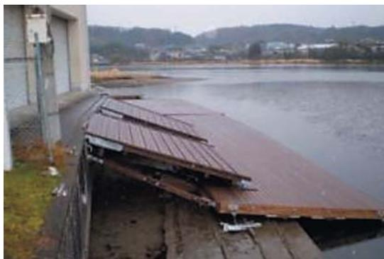
普段は川面に浮く栈橋が、水位低下のため河床に着いています。
