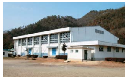
耐震工事が予定されている 北小学校屋内運動場
