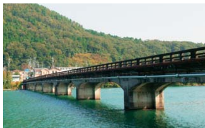
修繕が予定されている山川橋
