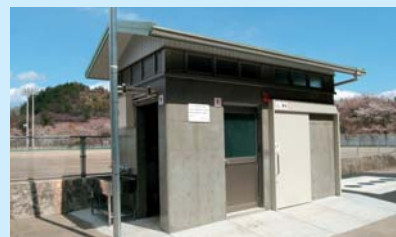
山楠グラウンドに新設されたトイレ
