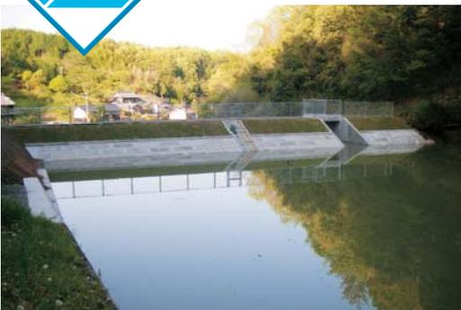
70余年の永きにわたり、防災、治水に貢献してきた鹿塩山中地区のため池ですが、老朽化が進み漏水や洪水時の崩壊等が心配されていました。そのため、平成19年度から「県営ため池防災対策事業」として改修工事を行ってきました。
