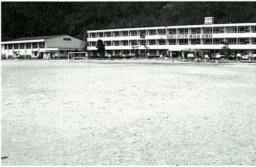
夜間照明施設の要望がある北小グラウンド
