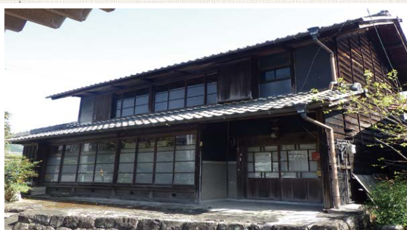
空き家解体支援事業を活用した結果…
