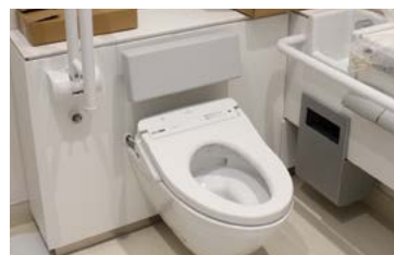
多目的トイレ
