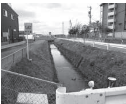
転落防止柵設置予定箇所 (雌鳥排水路)
