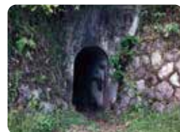
登山道入口のトンネル
