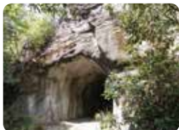
大きな岩盤に 空けられたトンネル!
